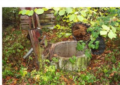
Im Garten hinter dem Haus befindet sich ein gemauerter Brunnenschacht. Dieser Brunnen lieferte bis zur Einführung der Wasserversorgung das Trinkwasser für Mensch und Vieh. Später entnahm man Wasser für den Garten. Der mit einem Betonring eingefasste und mit Blech abgedeckte Schacht hat von der der Erdoberfläche eine Tiefe von 350 cm bis zum 50 cm tiefen Wasser.
