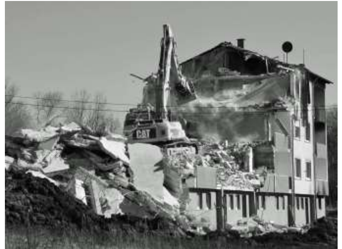
Auf dem Gelände der Alten Spinnerei fallen die ersten Häuser.
