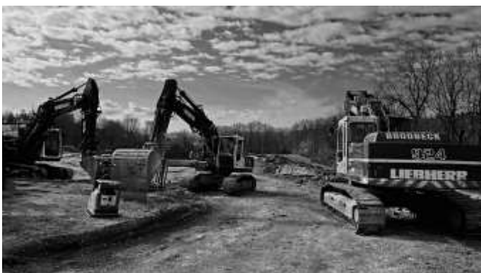
Alte Spinnerei: Die Bauplätze für die 43 neuen Wohneinheiten sind schon planiert
