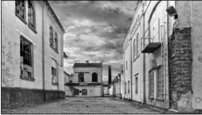
Batteurgebäude (links) und Fabrik (rechts), in der Mitte ist das Wasserkraftwerk
