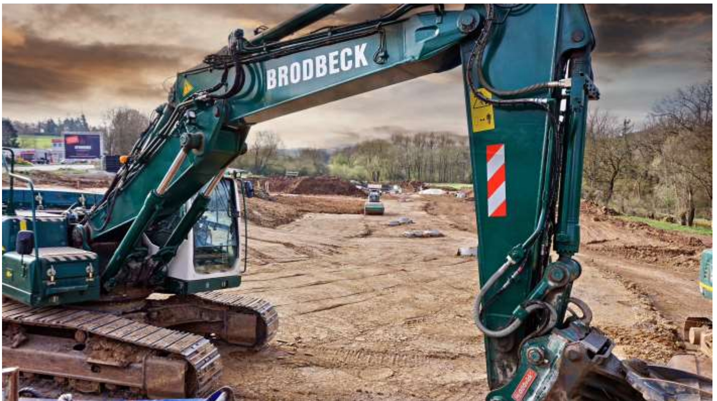
Die Bauarbeiten im Bereich der Alten Spinnerei sind gut vorangekommen
