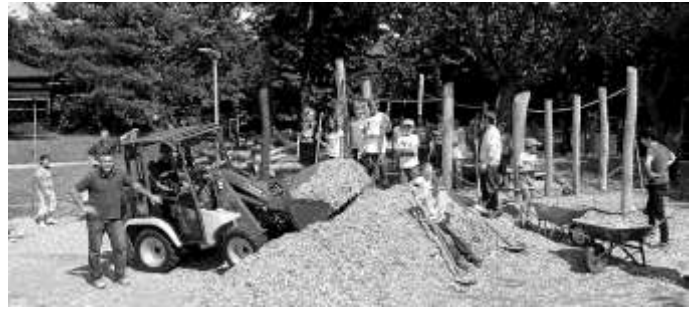
Arbeiten am Niederseilparcours
